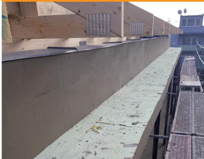
Ružomberok / bytový dom Cesta na Vlkolíneč 12
