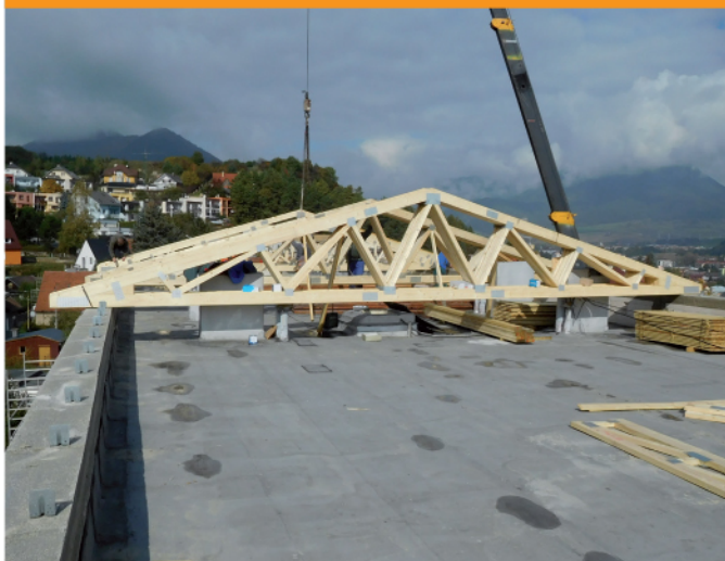
Ružomberok / bytový dom Cesta na Vlkolíneč 8
