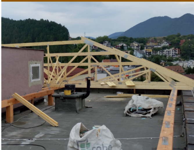
Ružomberok / bytový dom Cesta na Vlkolíneč 11
