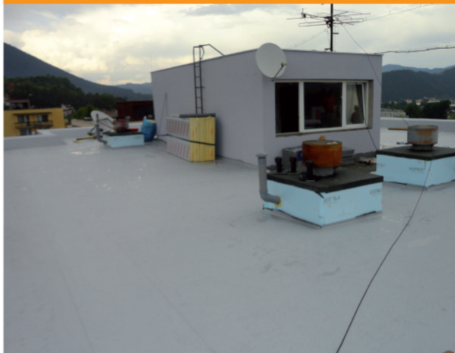
Ružomberok / bytový dom Cesta na Vlkolíneč 11
